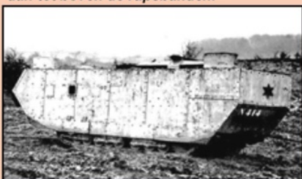
Het prototype van de Saint-Chamond tank. De pantsering van de zijanten loopt nog door tot over het onderstel, bij de productievoertuigen zou de pantsering om gewicht te besparen niet verder gaan dan tot boven de rupsbanden.
