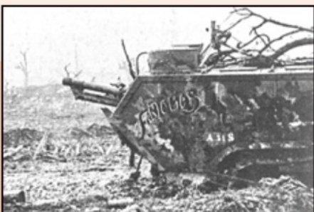
"Fantomas" is tank nr. 1 (verticale I) van de 3 e batterij (een nauwelijks zichtbaar ruiten aas) van de 31 ste AS (hier geschilderd als A31S). Het is een tank van het eerste type, zoals blijkt uit het platte dak. Op het dak staat een extra mitrailleur-affuit.
