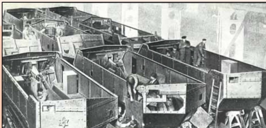
Saint-Chamond tanks in verschillende stadia van afbouw. In de tank links voor is het 75 mm kanon duidelijk te zien.
